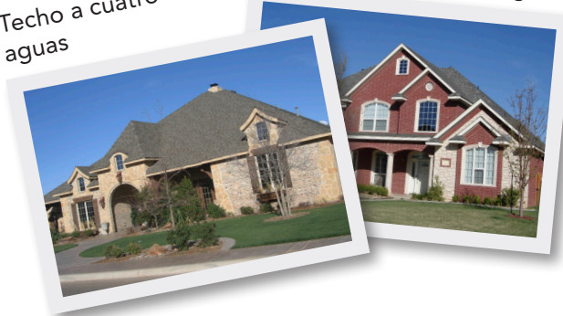
Techo a dos aguas
